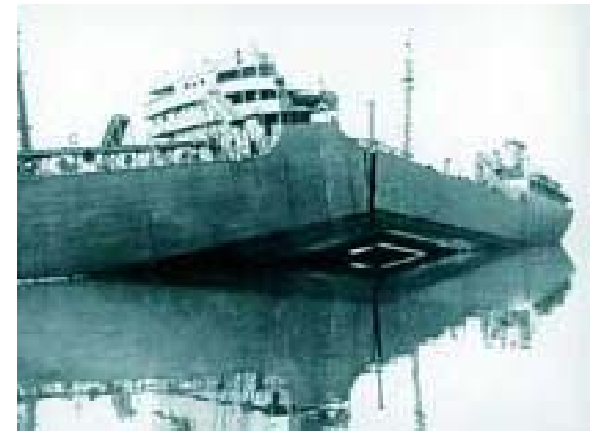
SS Schenectady, Nave cisterna interamente saldata rottasi in due parti nel 1943, quando era ormeggiata in porto.
